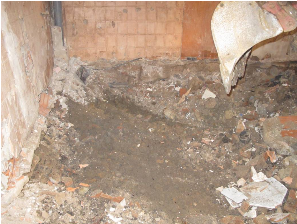
Foto 5: Inici de l'excavació de terres
