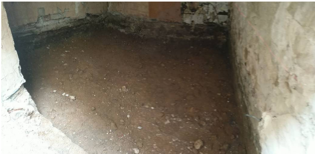
Foto 14: Final d'excavació. Parets oest i nord
