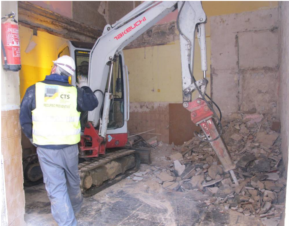
Foto 3: Inici dels treballs de demolició del paviment UE 1
