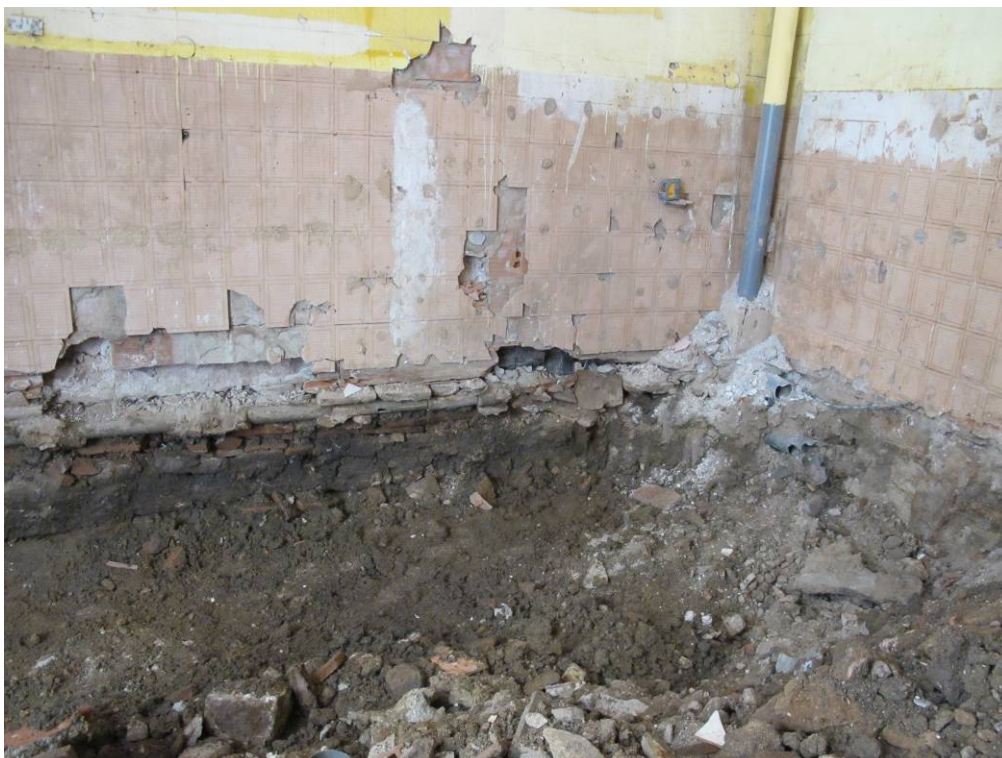
Foto 9: Procés d'excavació. Pareds oest i nord
