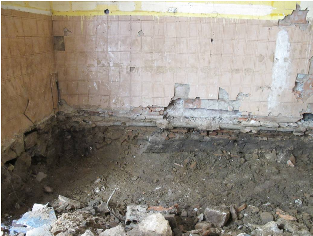
Foto 8: Procés d'excavació. Paret oest
