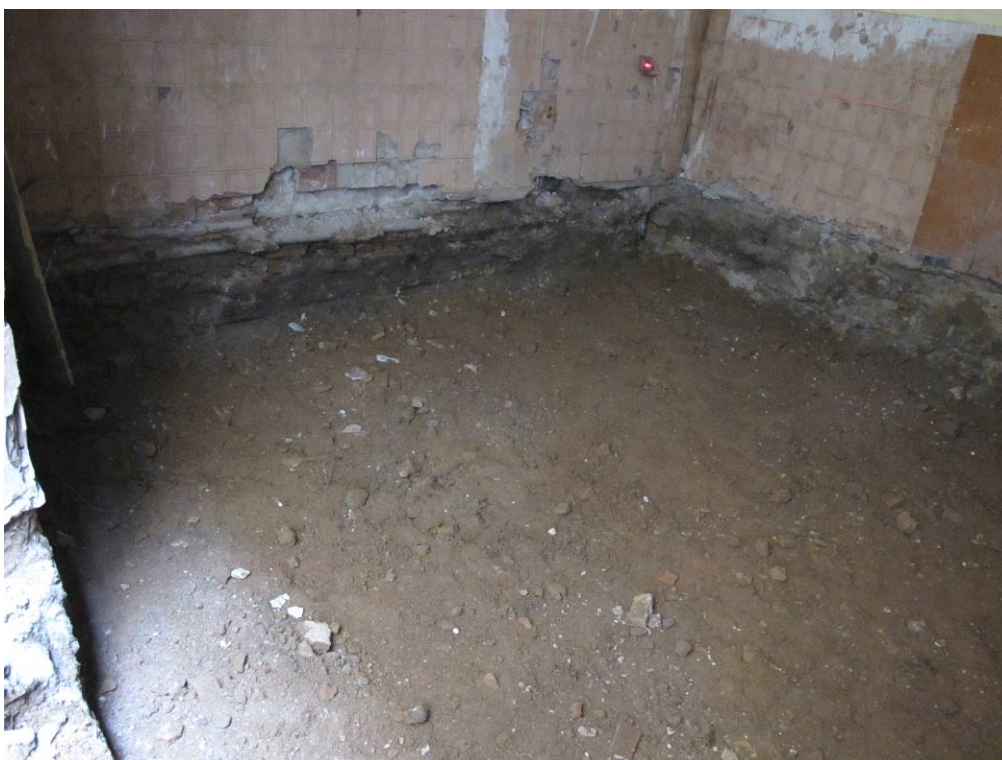
Foto 12: Final d'excavació. Pareds oest i nord
