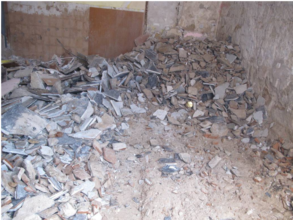
Foto 4: Procés d'extracció del paviment
